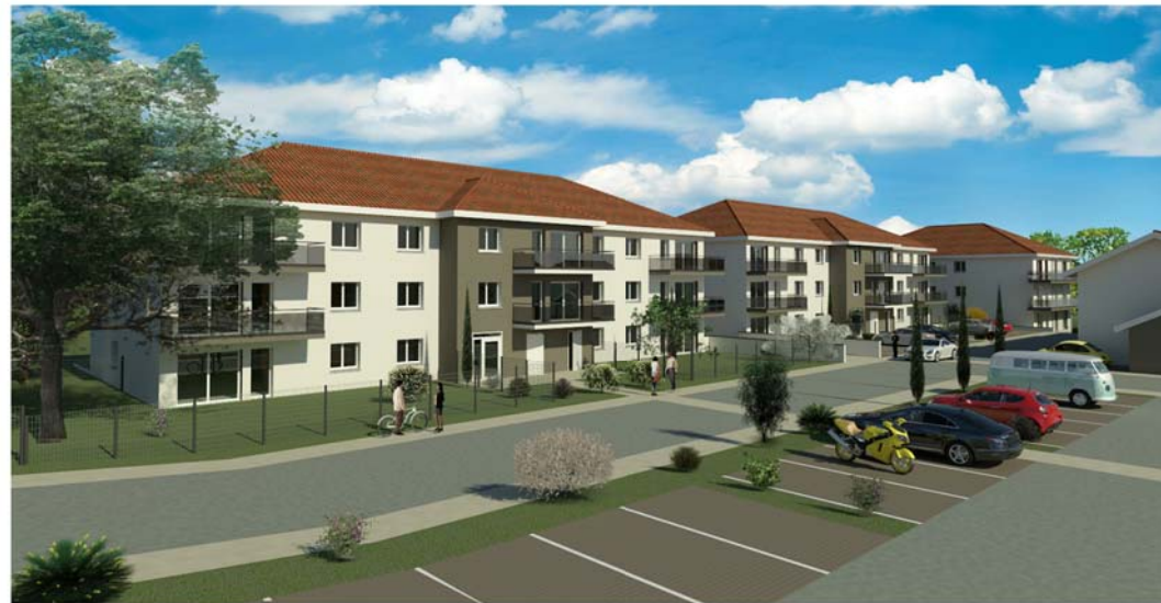
Logement B 0001 - T3
